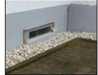
Abbildung 34: Beispiele von Objektschutzmaßnahmen (Überbogen, Geländemodellierungen, Aufkantung am Kellerfenster)
