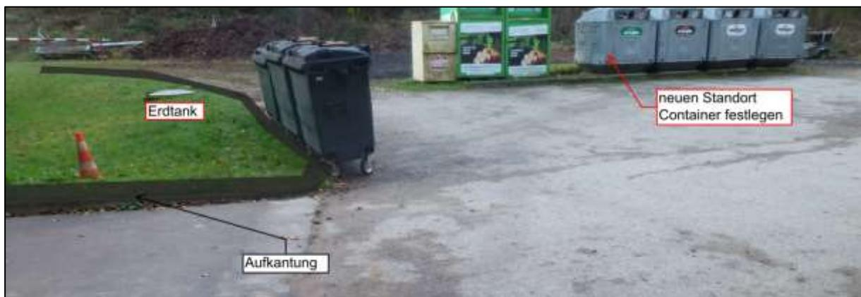
Abbildung 90: Visualisierung Aufkantung um Erdtank
